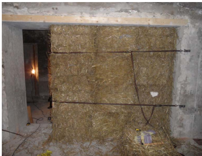
Obr. 1: Postupná montáž slaměné stěny v akustické laboratoři Fakulty strojní VUT v Brně
